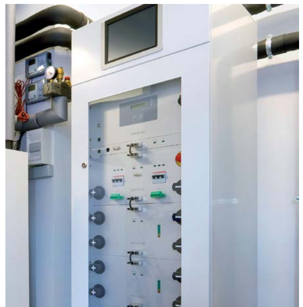
Batteriespeicher, 13,2 Kilowattstunden
