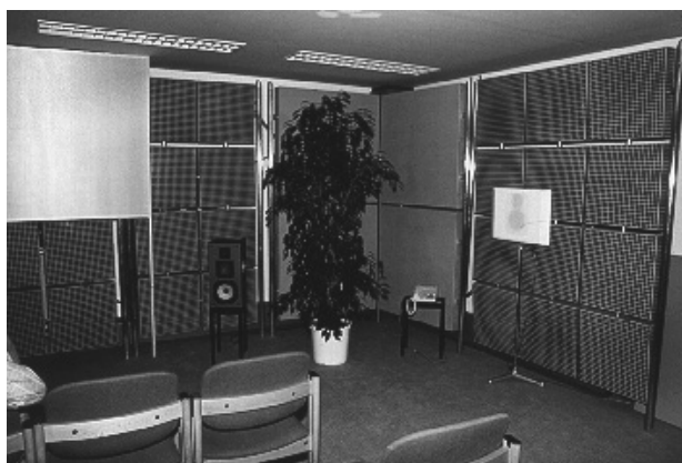
Bild 1: Der fertig eingerichtete Vorführraum: Hinter der Grünpflanze in der Raumecke stehen die Membran-Absorber, daneben zu beiden Seiten die porösen Absorber [3]
