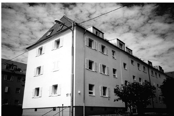
Bild 1: Photographische Aufnahme des Gebäudes in Stuttgart-Bad Cannstatt.
