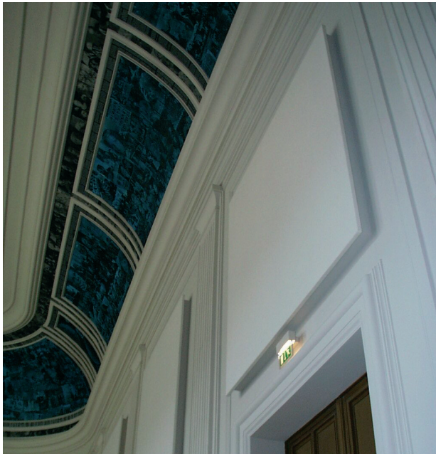
Bild 3: „Aula“, Verbundplatten-Resonatoren VPR nach [4] hinter einer Stoffverkleidung über den Türen.
