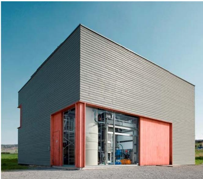
**Smart Cities: Im Projekt DEUS 21 wird Regenwasser gesammelt und in einer zentralen, modernen Membrananlage zu Trinkwasserqualität aufbereitet.**
