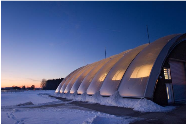
Versuchshalle (FTF) mit mehrlagiger Membranhüllen- Konstruktion am Fraunhofer IBP Holzkirchen © Fraunhofer IBP
