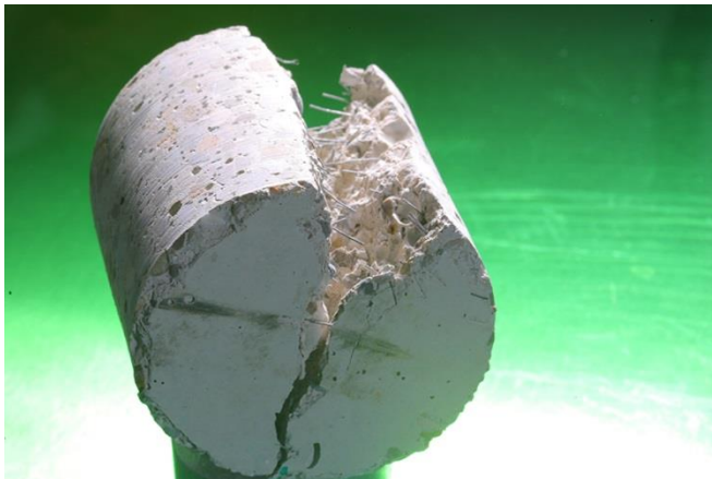
Bohrkern aus Stahlfaserbeton © Fraunhofer IBP
