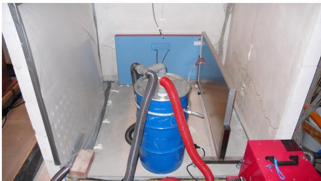
**Einsatz von verschiedenen Trocknungstechniken, Folienzelt, IR-Strahlungsheizplatten und Unterestrichtrocknungssystem zur Trocknung der Wände und des Bodens.**
