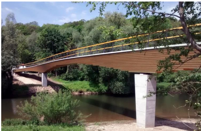
Holzbetonverbundbrücke, in der das System »H 2 O Wood-Controller« verbaut ist.
