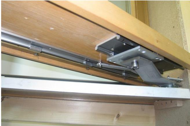
**Abb. 3 Ansicht des Fensterbretts von unten auf die Führungsschienen.**
