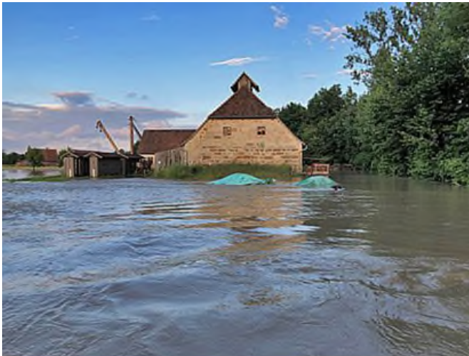
Vom Aisch-Hochwasser im Juli 2021 betroffene historische Gebäude.
