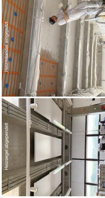
Abb. 2: Integration der Niedertemperatur-Deckenheizsysteme in den Gebäudebestand
