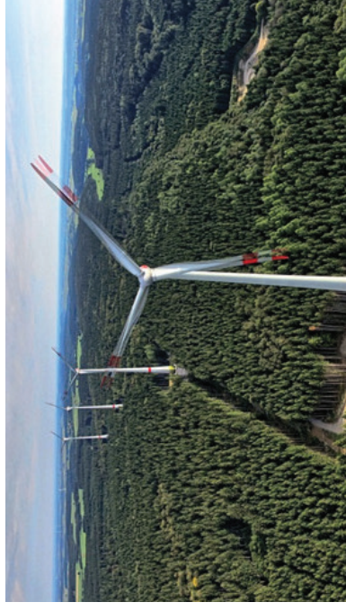
Abb. 2: Windenergieanlagen in der Gemeinde Fuchstal (Gemeinde Fuchstal)
