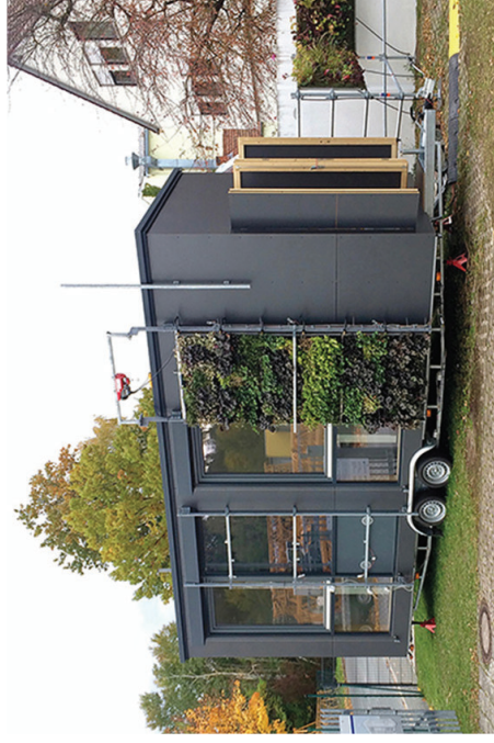
Abb. 1: Rednitzhembach, Technikum: EnOB: GreenFaBS Versuchstand. Referenzbüro mit DfL (links) und Aufbau mit Fassadenbegrünung und DfL (rechts) (Quelle: Roland Krippner)
