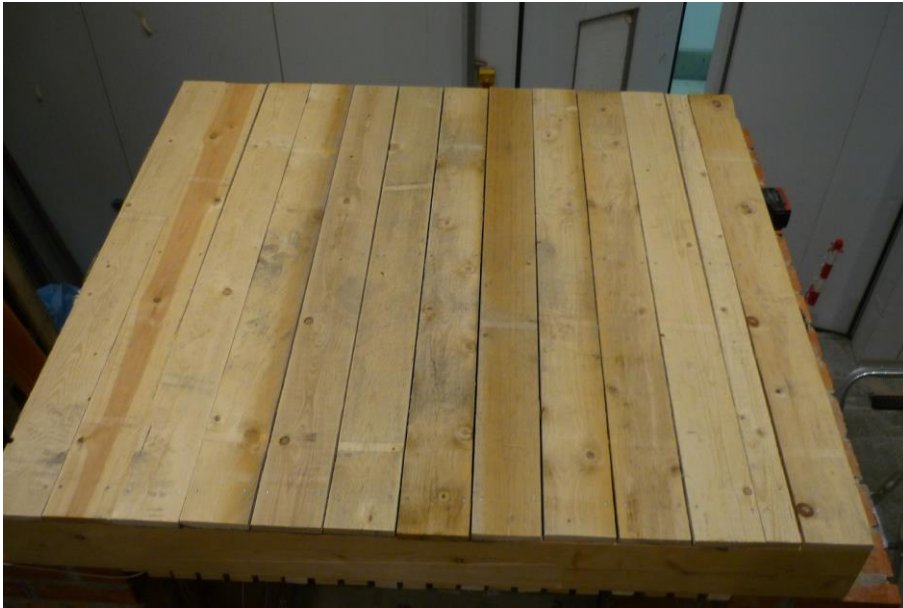
Bild 23: Oberseite des Deckenaufbaus (Raum C und D).
