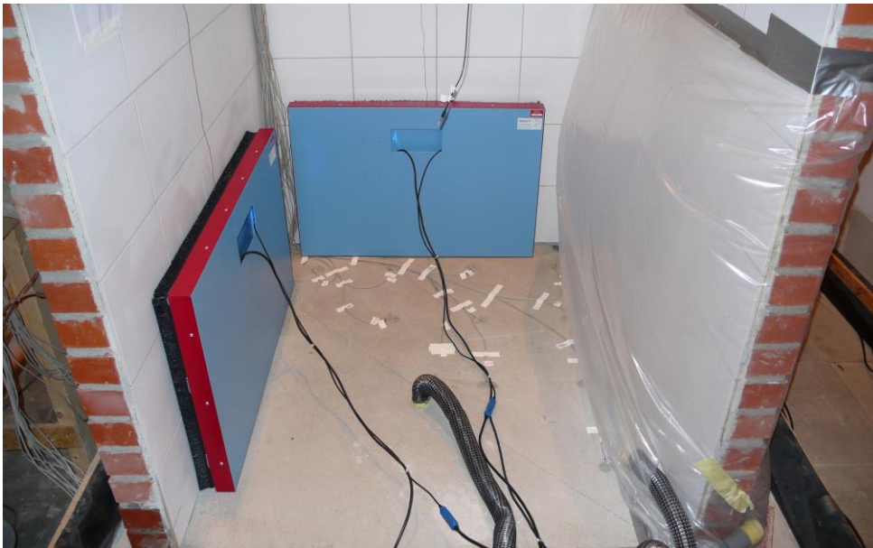
Bild 50: Trocknung der gefliesten Wände 16, 17, 18 und des Fußbodens in Raum H (4. Versuchsabschnitt).
