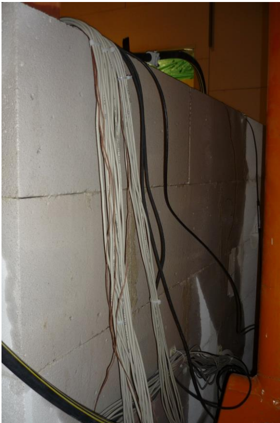
Bild 39: Durchfeuchtung der Wand 4 (Außenseite) bei der zusätzlichen Bewässerung von oben.
