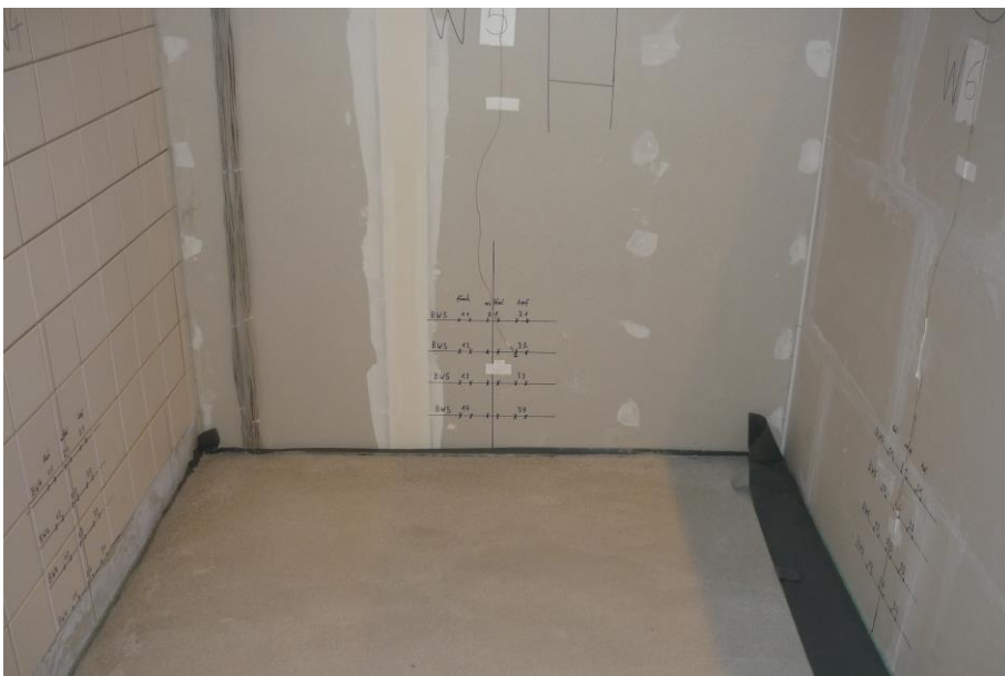
Bild 14: Fußbodenaufbau – Estrich (Raum A und B).
