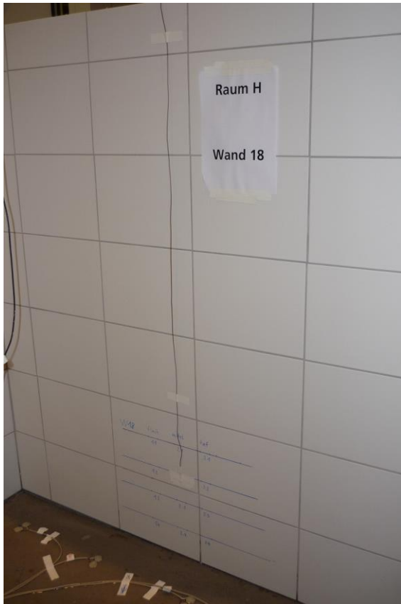
Bild 45: Wand 18 in Raum H (Innenansicht) nach drei Tagen Bewässerung.
