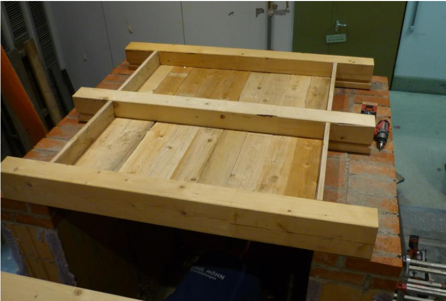
Bild 17: Holzbalken und Blindboden (Ebene 5) oberhalb der Putzträgerlattung von Raum D.
