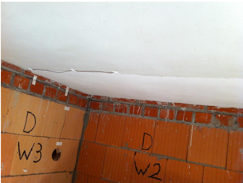
Bild 22: Deckenputz von Raum D.
