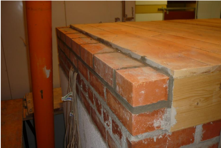
Bild 21: Ummauerung der Holzbalkendecke mit Kabeldurchführung (Raum C und D).
