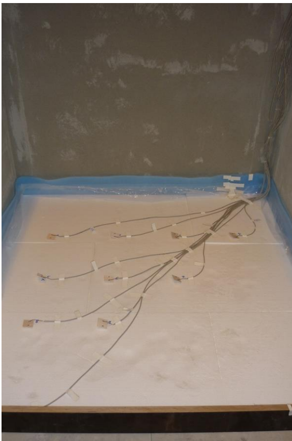
Bild 26: Fußbodenaufbau Raum G – untere Dämmebene – EPS-Dämmplatten.
