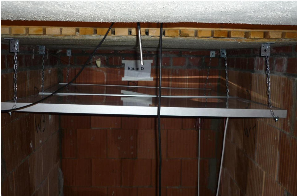
Bild 49: 3. Versuchsabschnitt, Raum D: Auf der Deckenunterseite installierte IR-Strahlungspaneelle.
