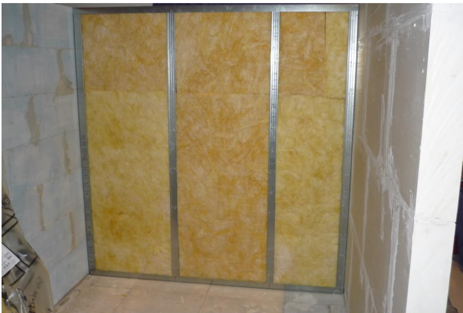
Bild 10: Dämmung von Wand 5 (Leichtbauwand).
