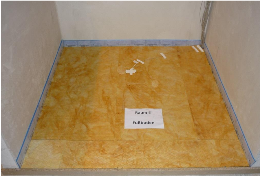
Bild 25: Fußbodenaufbau Raum E – obere Dämmebene - Mineralfaserdämmplatten.
