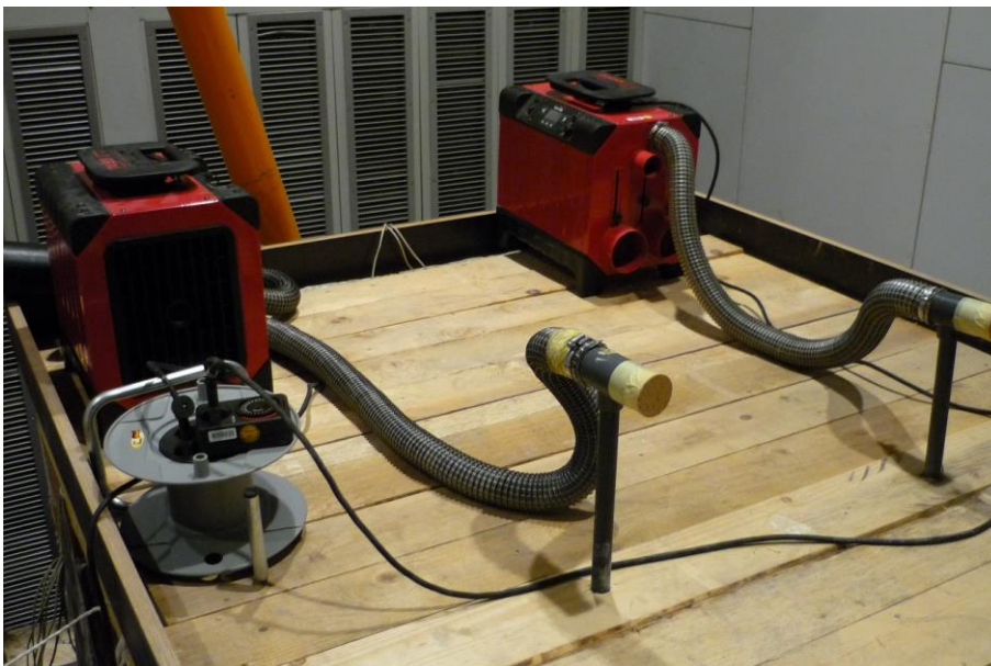
Bild 48: Mechanische Trocknung der Deckenaufbauten (Oberseite).
