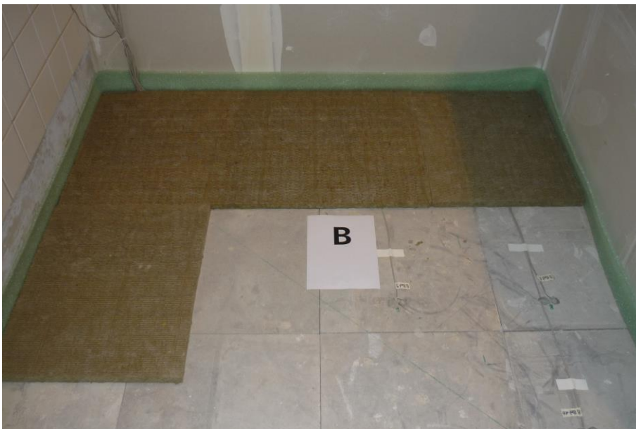
Bild 12: Fußbodenaufbau – Dämmung (Raum B).
