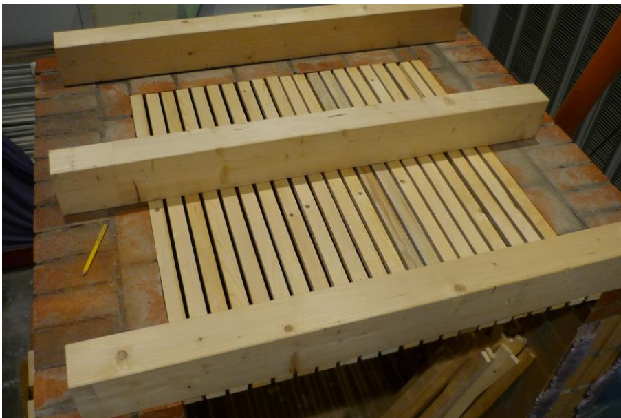
Bild 16: Holzbalken und Putzträgerlattung von Raum C.
