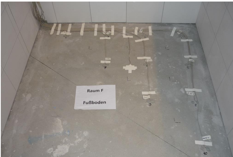
Bild 30: Fußbodenaufbau Raum E, F, G und H – Estrich.
